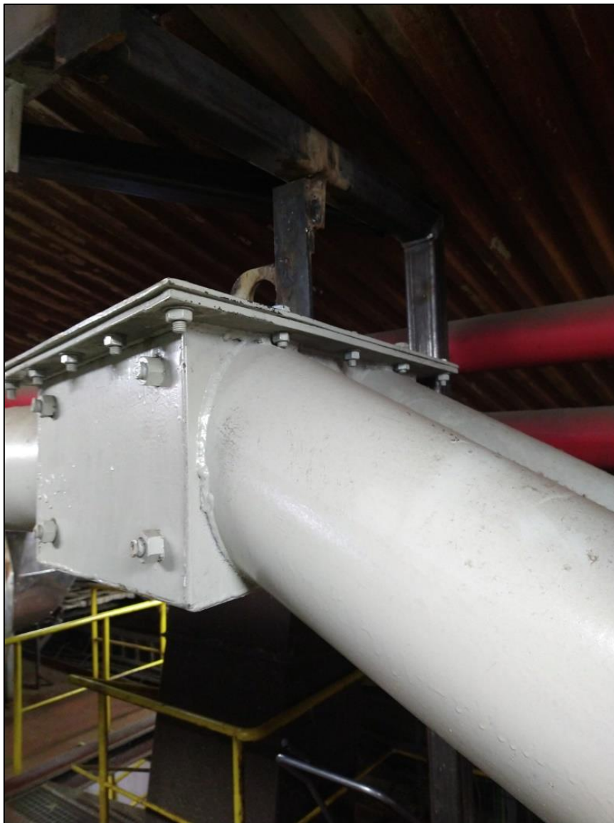
Figur 4.11: Samlingskasse med vinkel på innløp
