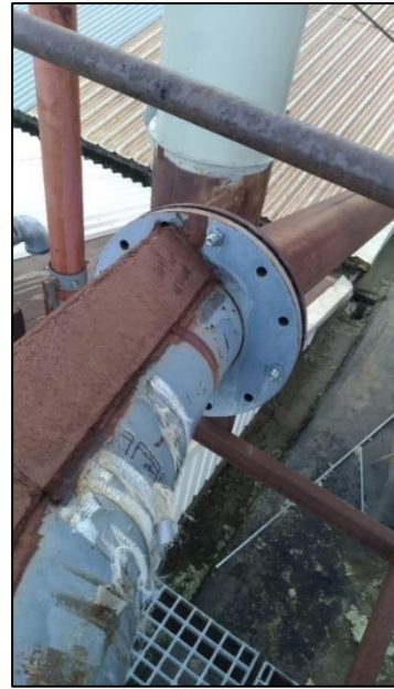
Figur 4.9: Flens på rør
