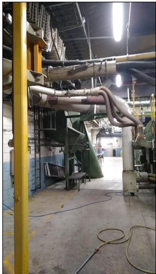
Figur B.6: Resten av avsug nettverk som også er koblet på filter
