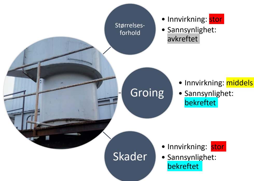
Figur 5.3: Analyse av feil på syklon
