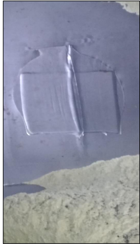
Figur B.10: Lappet slitasje
