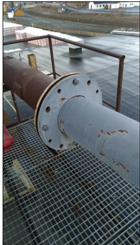
Figur B.1: Flens før syklon mangler bolter
