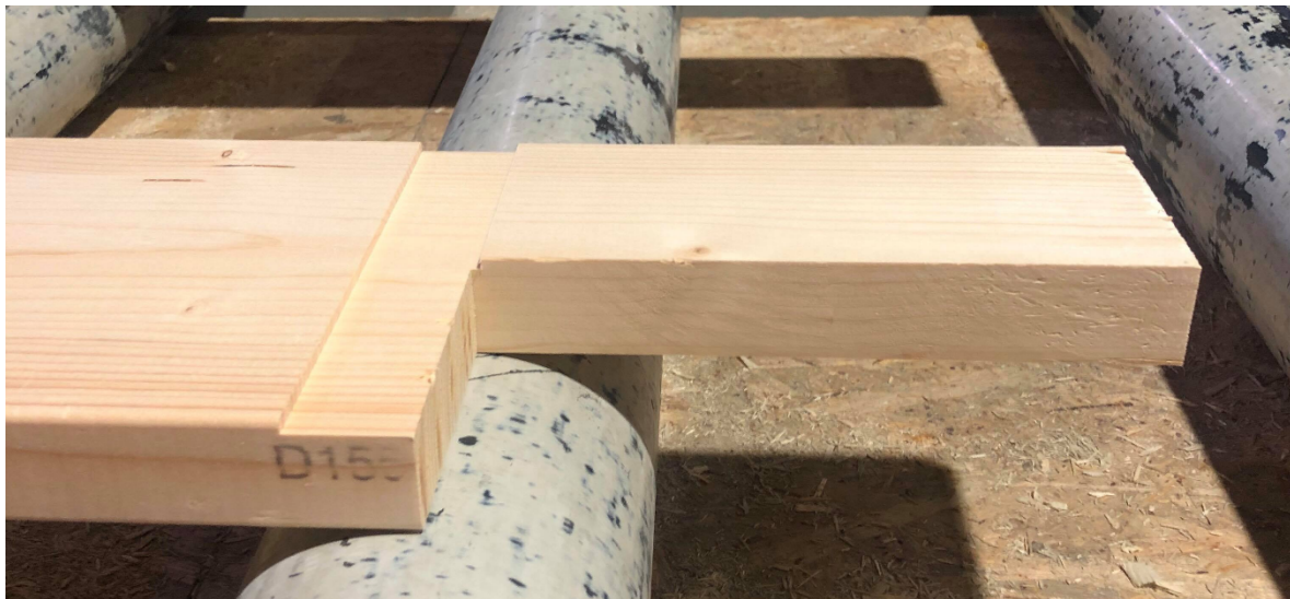
Figur 2.5: Konstruksjonsvirke kappet og utfrest for innfestningspunkt
