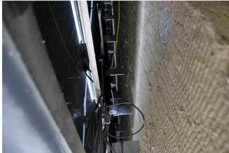
Figur 20 – BIPV-fasade med luftet kledning fra Brynseng skole i Oslo.
