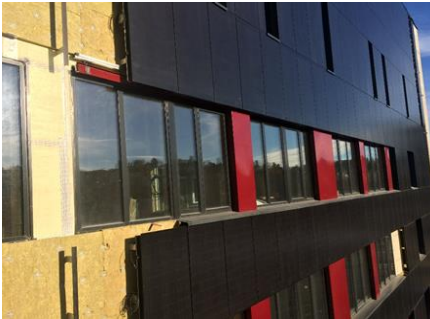
Figur 19 – BIPV-fasade med luftet kledning fra Brynseng skole i Oslo.
