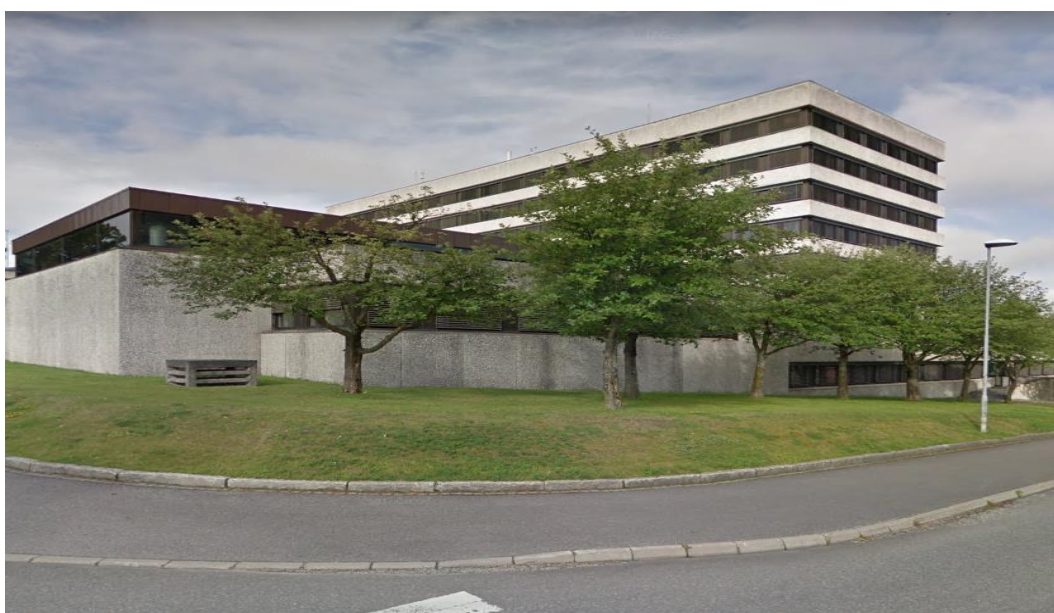
Figur 50 – Fylkeshuset sett fra øst.
