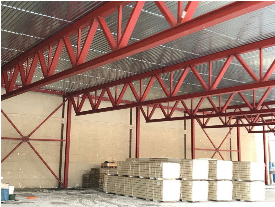
Figur 20: Fagverk i takkonstruksjon [16].
