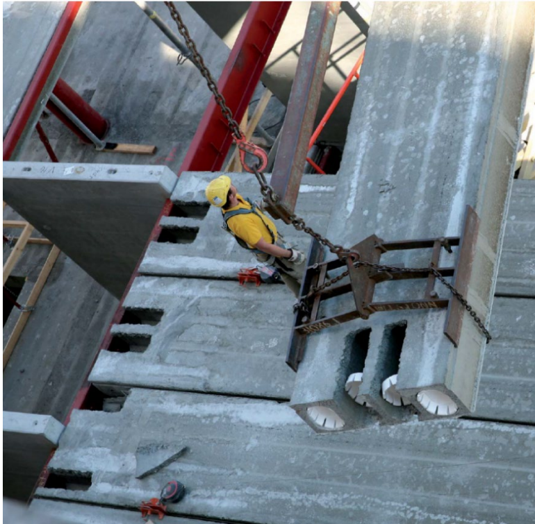
Figur 34: Montering av hulldekke [37].
