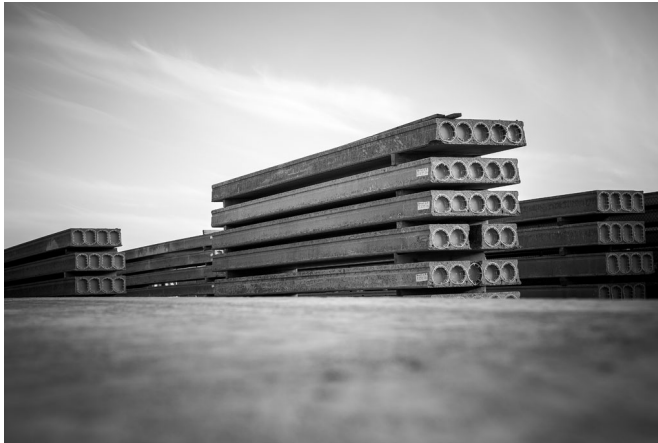
Figur 32: Prefabrikkerte hulldekke elementer [35].
