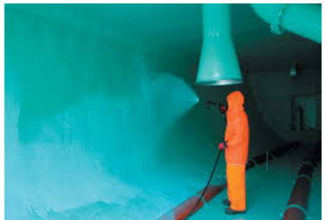
Figur 2 - Vasking av fiskebrønner, Foto Veso 2006
