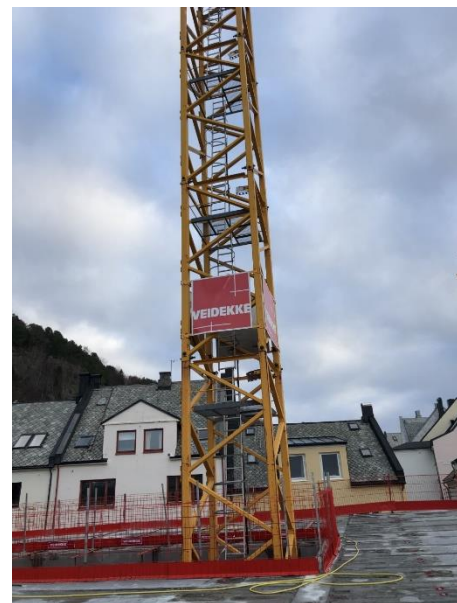
Kran som går gjennom taket på bybadet for å få tilstrekkelig rekkevidde på byggeplassen.
