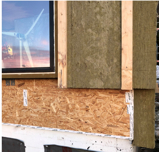
Figur 3.3: Rockwools Redair Flex system på ytterveggene. Foto: Lindberg&Thorud
