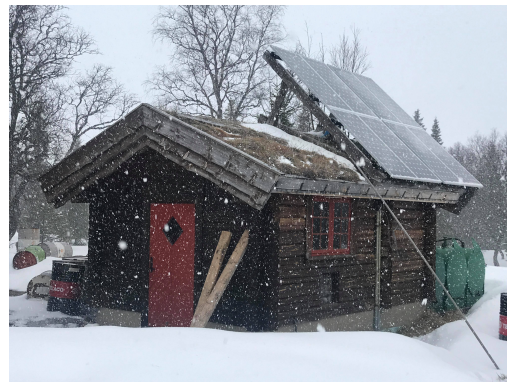
Aggregathus med solcellepaneler
