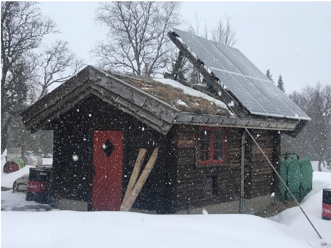
Figur 4.9: Solcellepaneler på aggregathus
