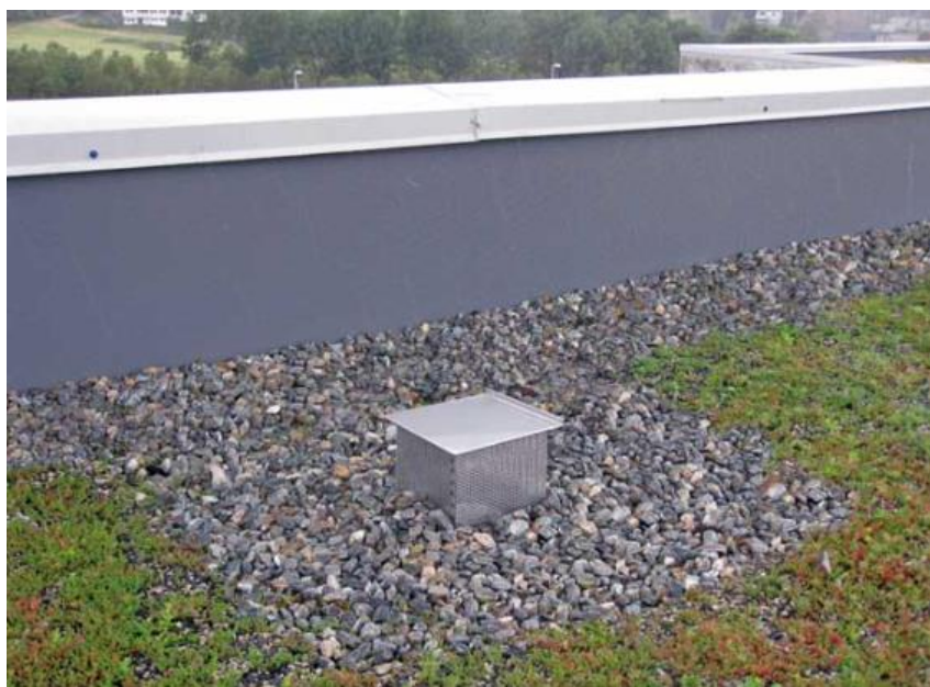
Figur 2.3.4.a. Eksempel på inspeksjonskum for sluk i sedumtak. (1)
