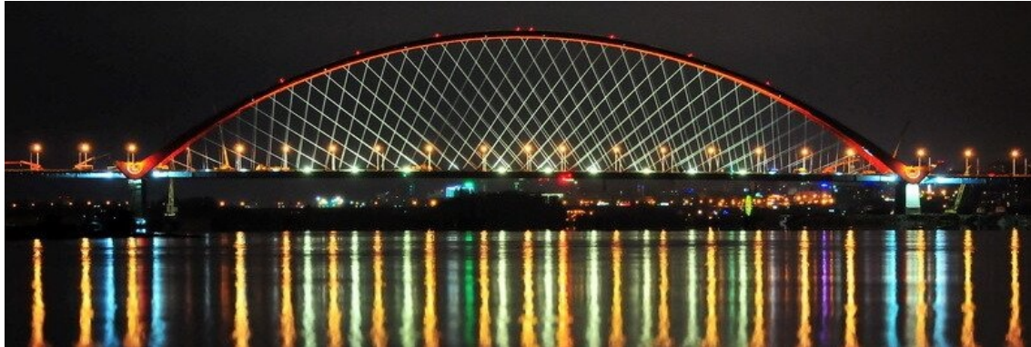
Figur 2.10: Bugrinsky bridge i Russland som eksempel på nettverksbuebru i stål. [19]
