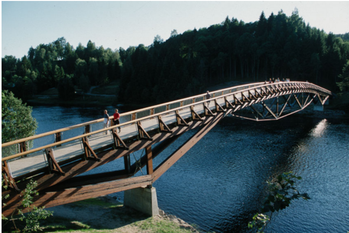
Figur 2.9: Kjærra bru over Glomma som eksempel på hengverksbru. [18]
