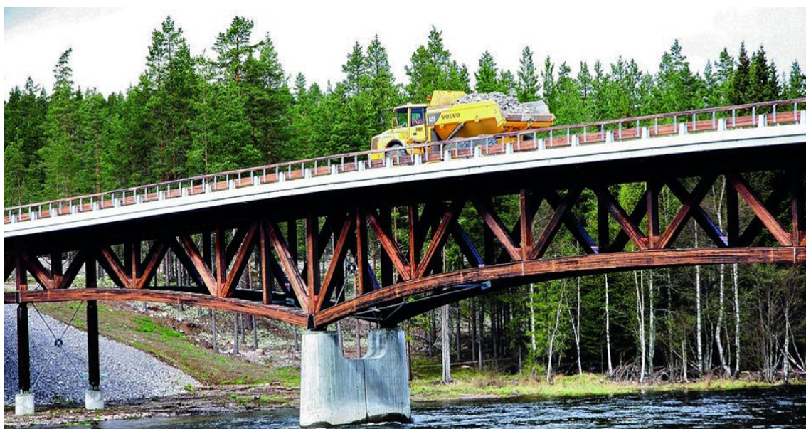
Figur 2.11: Verdens sterkeste trebru, utformet som fagverk, lokalisert på Rena.[20]
