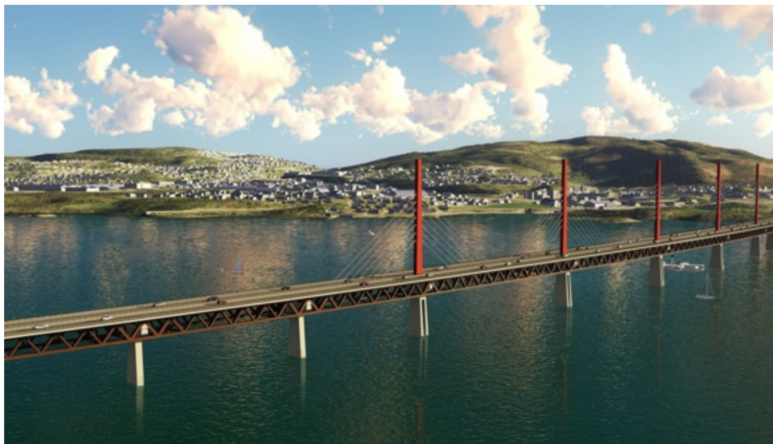
Figur 2.12: Mulighetsstudie av ny Mjøsbru i tre, på bildet utført som en skråstagbru. [21]
