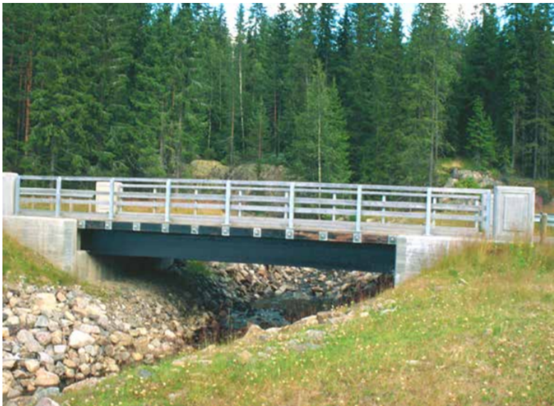
Figur 2.6: Grylla bru som eksempel på en bjelkebru. [3]
