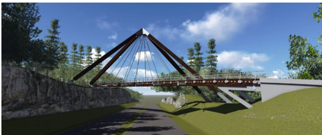
Figur 2.8: Skisseprosjekt av sprengverksbru, utført av Multiconsult. [17]
