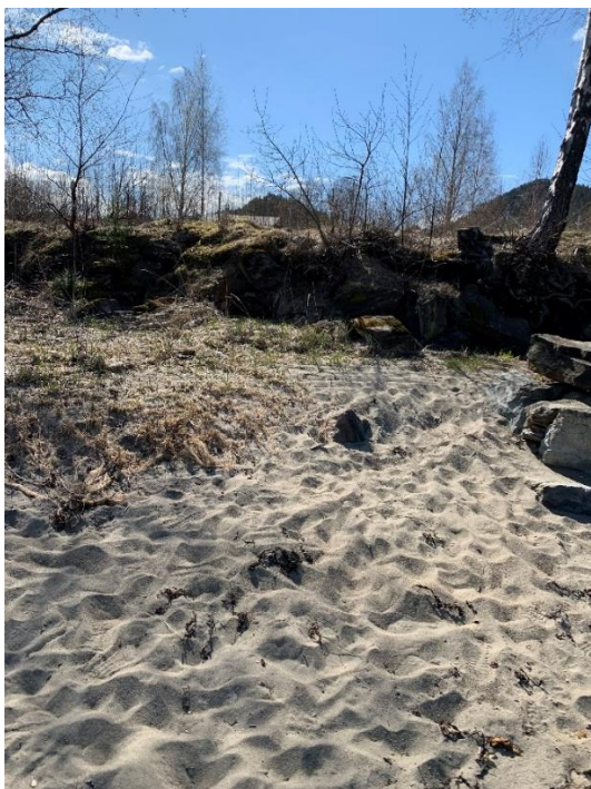
Figur 7.12 Fylling under Havnevegen
