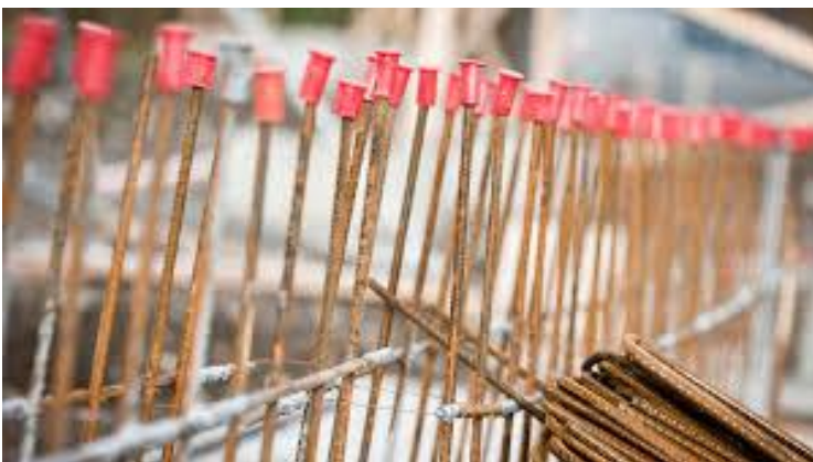
Figur 31. Viser vernehylser på oppstikkende armeringsstenger
