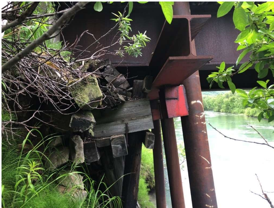
Figur 4: Opplager i akse A. Foto med tillatelse fra Arne M. Selberg (Juli 2019)
