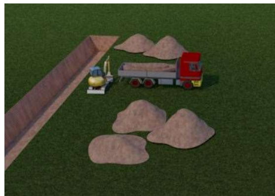
Massehåndtering på anlegg
