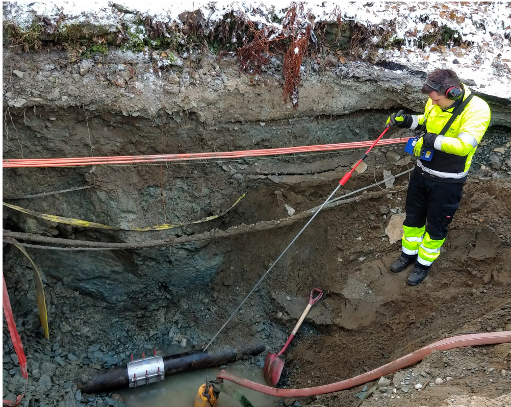
Figure 1.2: A Trondheim Vann og Avløp professional listening for leakages
