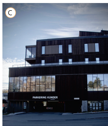
Figur 5.18: Fasade og inngang til parkeringshus ved Sverresborg senter
