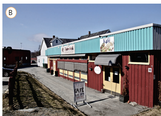
Figur 5.106: Kaféen på Vegamot holder til i et slitt bygg, men har gode solforhold.
