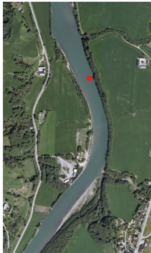
Figur 49. Flybilde av Jaktøya tatt i 2009 (StatensKartverk, 2009). Erosjonshullet er markert med rødt.
