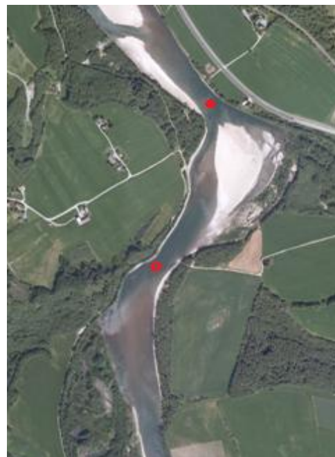
Figur 39. Flybilde av Kåsa (nederst) og Øyan (øverst) tatt i 2009 (StatensKartverk, 2009). Erosjonshullene er markert med rødt.
