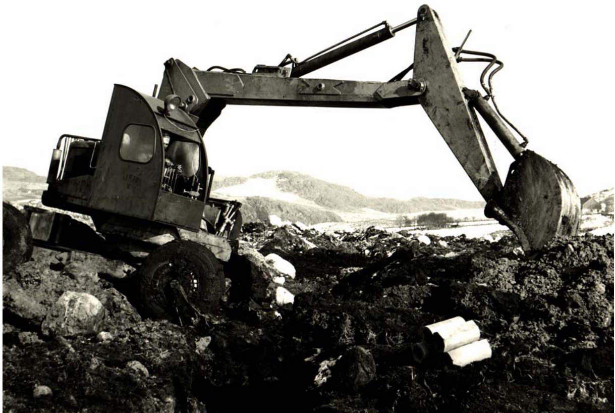
Fig. 3.5 Brøyt X. Produsert av Brødr. Søyland – Mek. Verksted, Bryne. Produksjonsår 1956. 22
