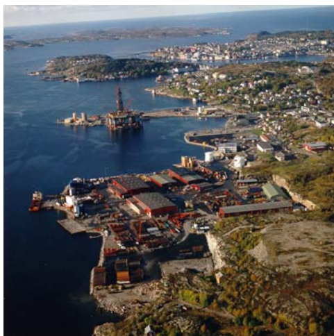
Statoils forsyningsbase i Kristiansund ved Vestbase AS (Foto: Vestbase AS)
