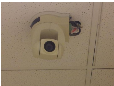
Figur 11 et av kameraene på testlab, montert i taket.
