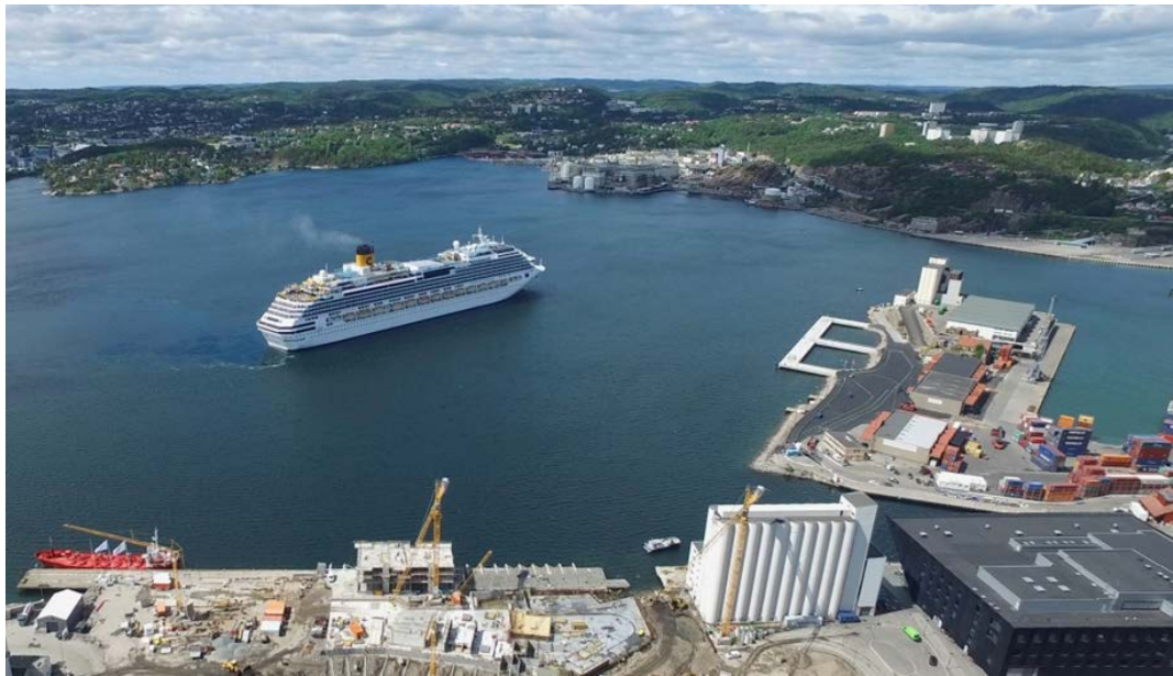
Figur 11. Cruiseskipskaia i Kristiansand har siden august 2018 kunnet levere 16MVA høyspent strøm med 60 Hz frekvens (foto: Kristiansand Havn).
