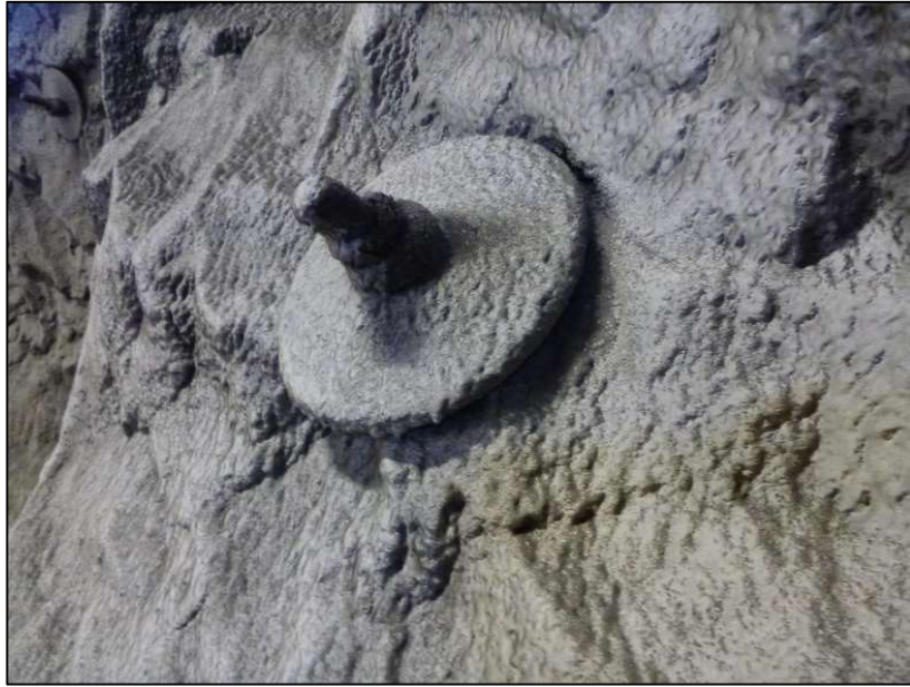
Figur 34 Overflaten til bergmassen ved den sprengte konturen under ingeniørgeologisk kartlegging.
