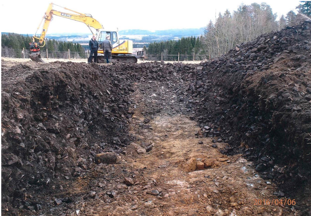
Fig. 6.12: Kulturlag med bryggestein på gården Hofstad, Sparbu. Fjernet under bygging av nytt uthus. Foto: Frode Kristiansen, Nord-Trøndelag fylkeskommune.
