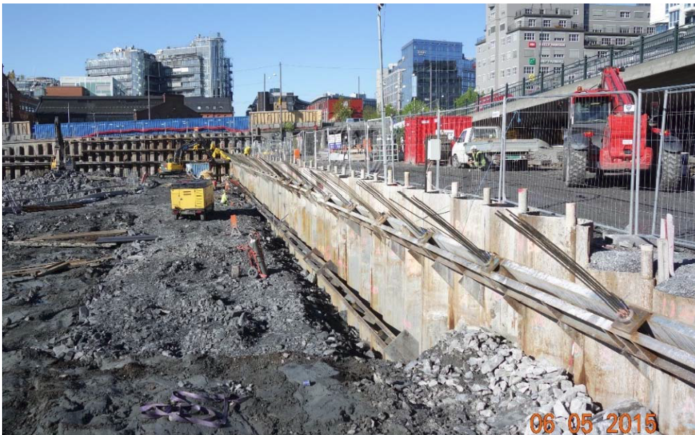
Figur 5.6: Situasjonsbilde av spunten langs E18 rampene tatt den 06.05.15. Mottatt fra NGI
