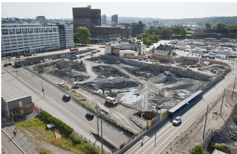
Figur 5.3: Oversiktsbilde av byggegropa underveis i byggefasen den 03.07.15. Bildet er hentet fra Statsbygg sine nettsider, foto: Ken Opprann/Statsbygg.
