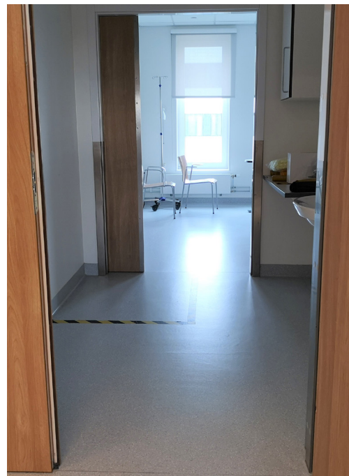
Bilde 42: Det er ikke mulig å se hodeenden av sengen fra korridor på Kalnes. Bildet er tatt av kontaktsmitteisolatet, men situasjonen vil bli den samme ved de andre rommene
