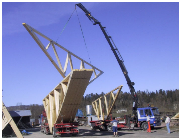
Bilde 2 Takstoler heises på plass (1-2-tre, u.d)
