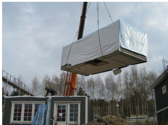
Bilde 1 Volumetrisk husmodul heises på plass (Canderas, u.d)
