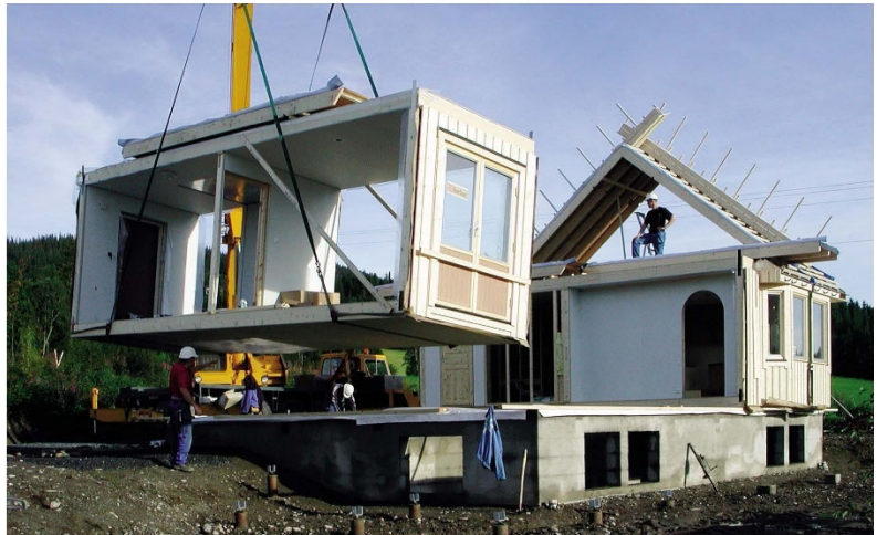
Bilde 9 Løft av modul på småhusprosjekt. Modulene blir heist på plass på fundamentet. Legg merke til midlertidig avstivning av modulen (Ramstad, 2014)
