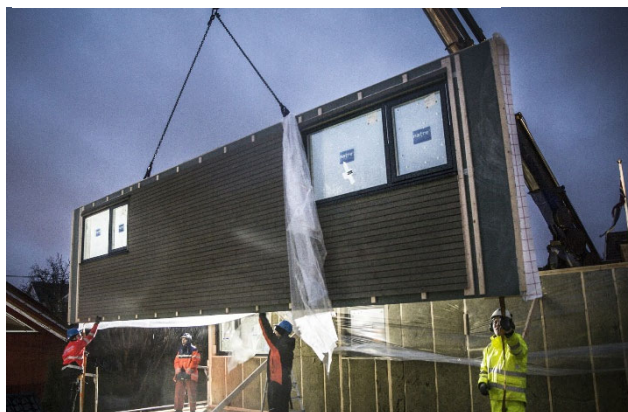
Bilde 3 Lukkede elementer heises på plass (Jensen, 2017)
