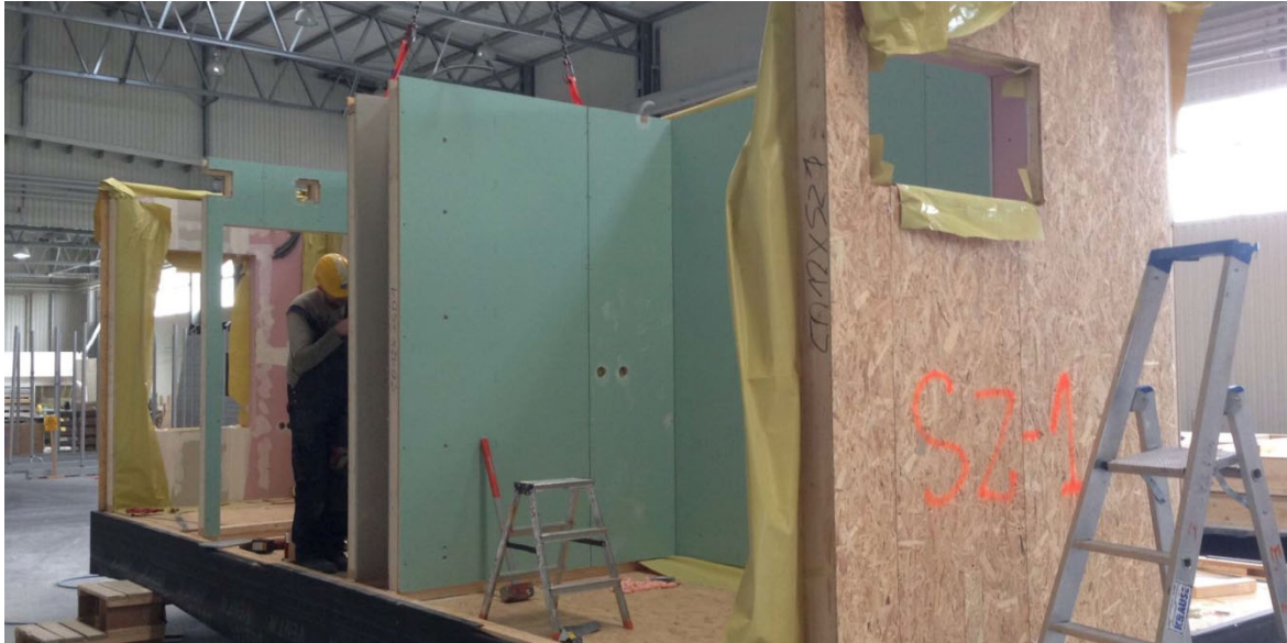
Bilde 7 Konstruksjon av moduler i fabrikk (Haugen, 2015)
