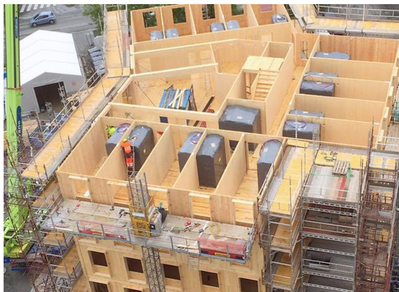
Bilde 4 Installasjon av baderomskabiner Moholt 50/50 (Veidekke, 2016)
