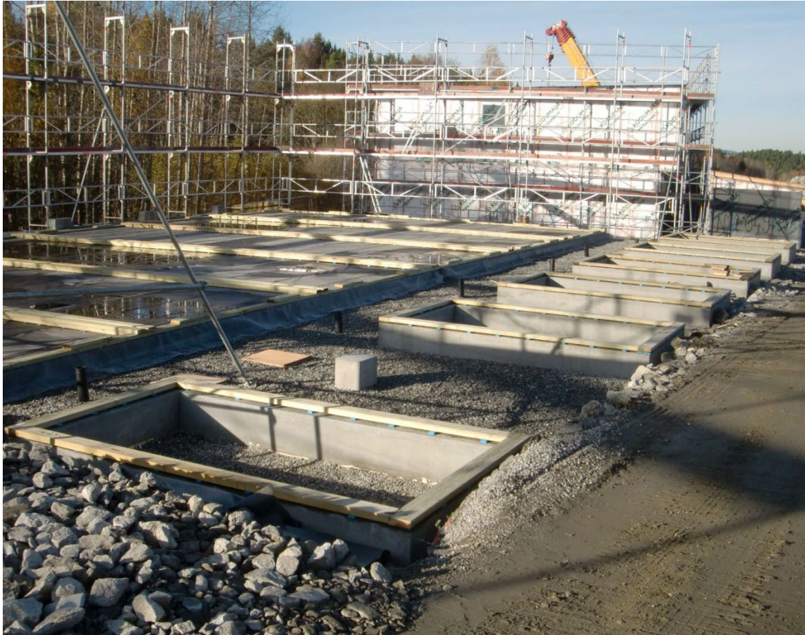
Bilde 8 Fundamentet for sportsboder i front og modulene i bakkant klart for montering (Haugen, 2015)
