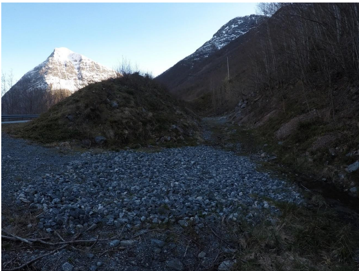
Figure 24 Terminal wall along Rv. 70, Hjørundfjorden, Ørsta
