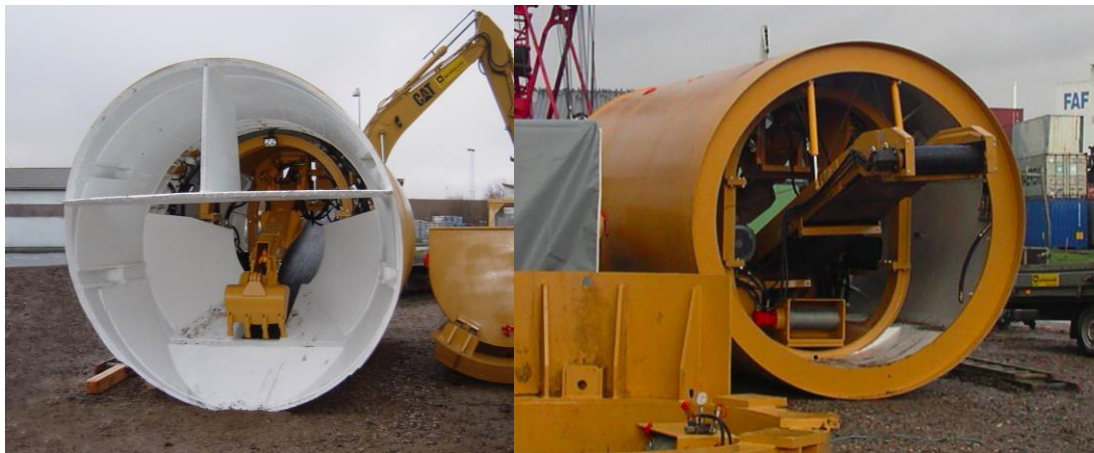
Figur 14. Åpen tunneleringsfront sett forfra (venstre) og bakfra (høyre) (Steg Entreprenør og Østergaard, 2019).
