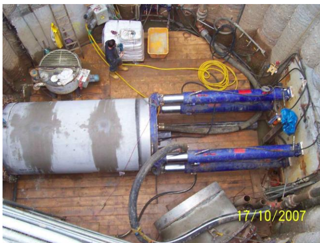
Figur 15. Bilde tatt ned i en pressgrop. Et rørsegment blir presset inn i grunnen av hydrauliske sylindere (Steg Entreprenør og Østergaard, 2019).
