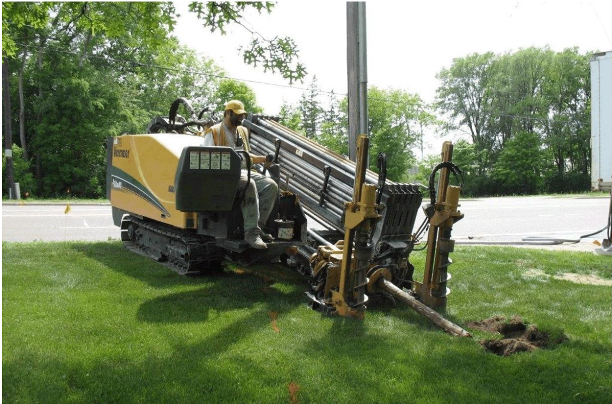
Figur 7. Beltegående maskin som brukes ved styrt boring opereres fra overflaten (Universal Services, 2017)
