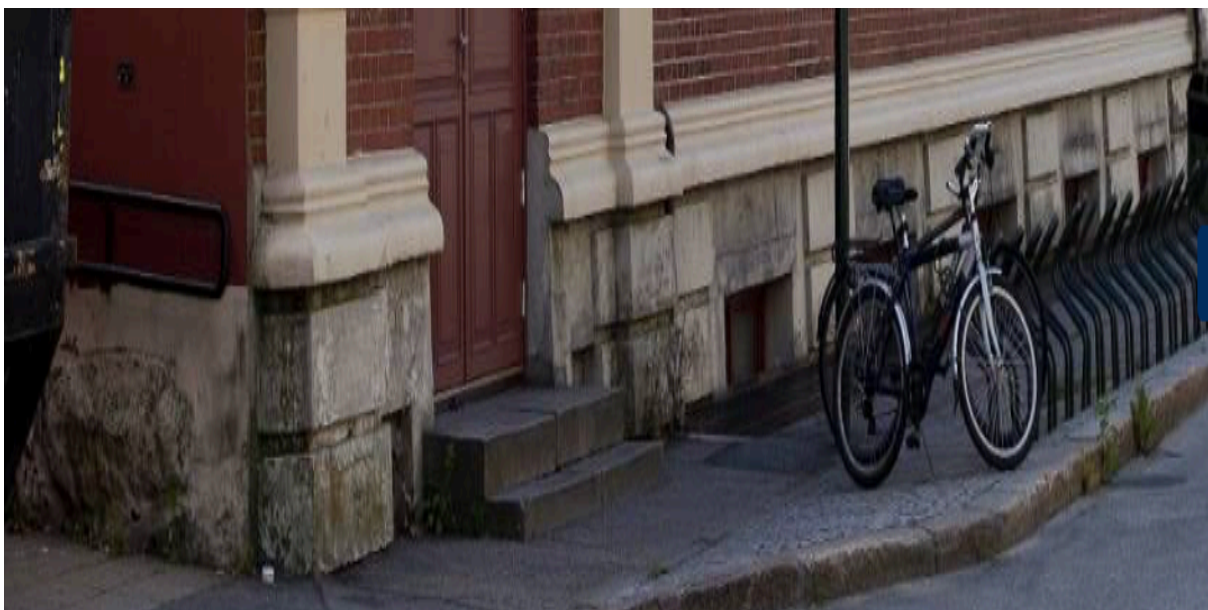
Figur 5.) Innzoomet detalj fra bilde figur 2. Her ser man tegn på saltutslag og saltkryslisering som er på gang på grunnmuren til Kongens gate 54. Foto: Jørgen Steffensen, Fvn. Hentet fra: https://www.fvn.no/nyheter/lokalt/i/6Mr1r/Frykter-ras-fra-murbygg#&gid=1&pid=3
