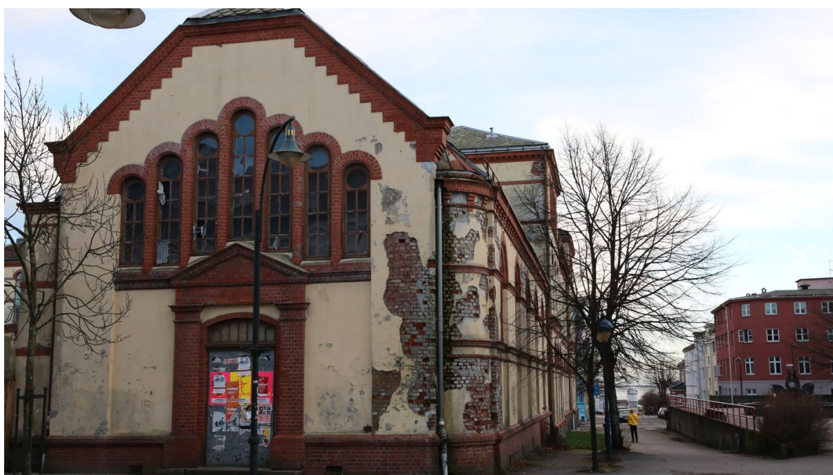
Figur 3.) Bildet ovenfor viser Nordre fasade av Kongensgate skole i Kongensgate 45. Foto:
