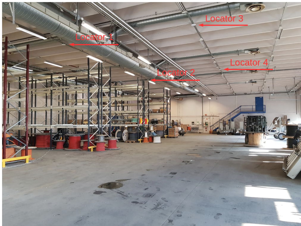
Figur 3.2: Bilde av lageret, med plasseringen av QILS Locators markert med piler.
