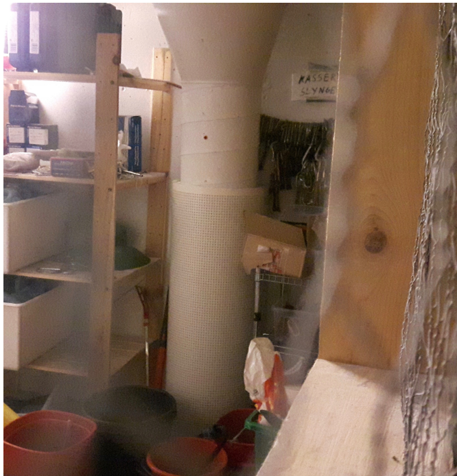
(a) Diffus innblåsning gjennom kanalventil.
