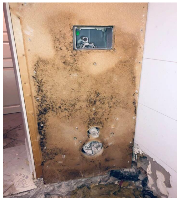
Fig. 11: Feil som kan oppstå uten ordentlig bruk av membran. Fuktskader både foran og bak innbyggings sisterner. Foto: Kanu 2019
