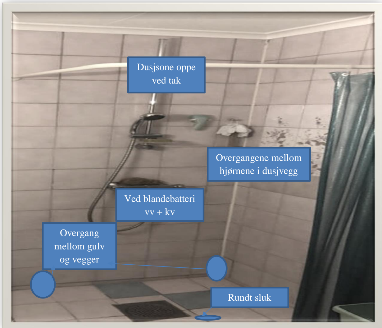
Fig. 2: Baderom som viser målepunkter som har blitt målt
