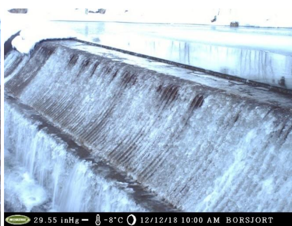
Figur 23: Bilde tatt av inntaksrista klokken 10:00, 12.12
