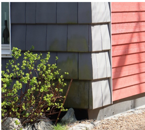
Figur 39: Sørvestveggen til Damsgårdsveien 47 og 55, Bergen (2010)
