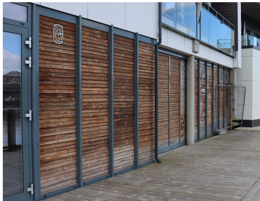
Figur 51: Nordveggen til Damsgårdsveien 73, 75 og 77, Bergen (2017)
