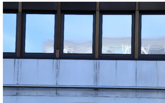
Figur 15: Nordveggen til Dronningens gate 15, Trondheim (1986-1999)
