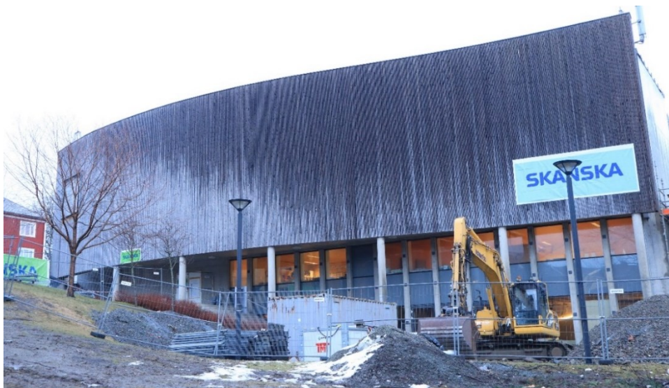
Figur 48: Nedbør på nordvestveggen til ubehandlet trevirke. Christian Frederiks gate 20, Trondheim (2006)
