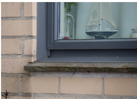
Figur 22: Nordvestveggen til Georgernes Verft 20, Bergen (2000)
