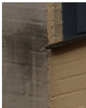
Figur 23: Sørøstveggen til Georgernes Verft 17, Bergen (2000)
