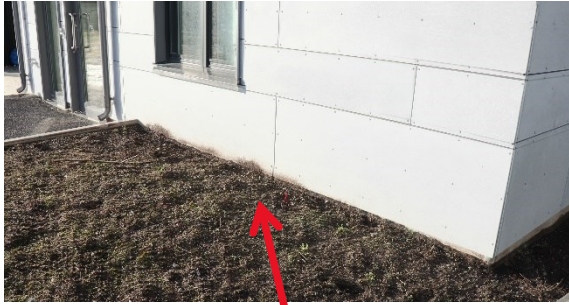
Bilde 1 – Sørøst bygg 3:
