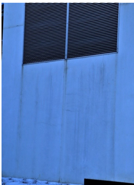
Figur 28: Nordøstveggen til Olav Kyrres gate 10, Trondheim (2013)
