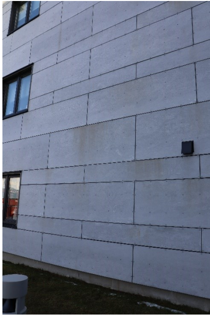
Bilde 2 – Sørvest, bygg 4:
