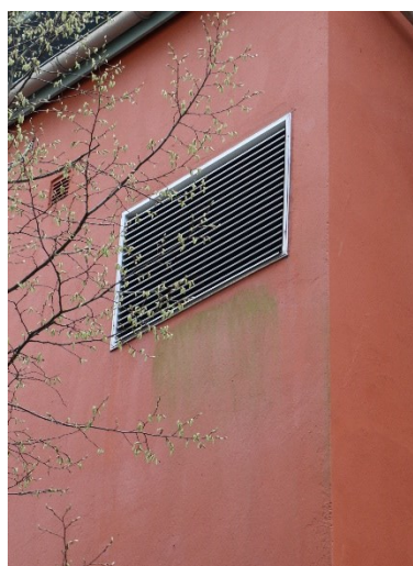
Figur 40: Nordøstveggen til Georgernes Verft 22, Bergen (2000)
