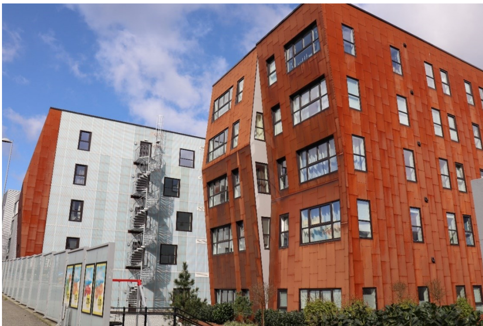
Figur 54: Damsgårdsveien 86, Bergen (2014). Fasader mot sør og øst.
