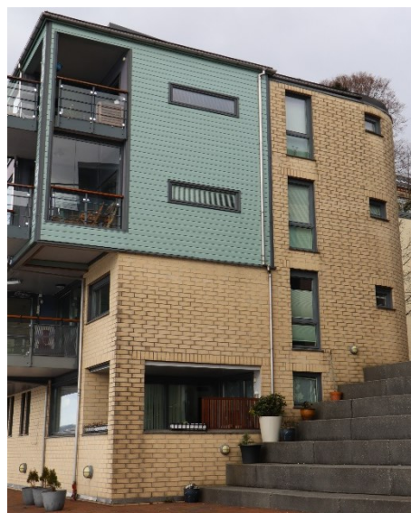
Figur 44: Sørøstveggen til Georgernes Verft 18, Bergen (2000)
