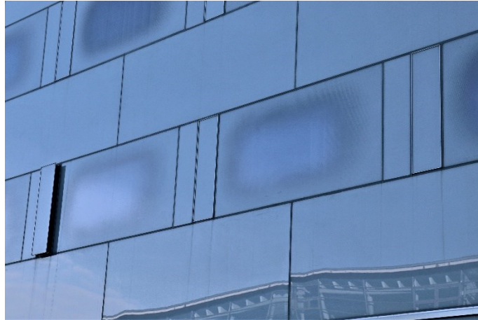
Figur 25: Nordvestveggen til Brattørkaia 1, Trondheim (2012)
