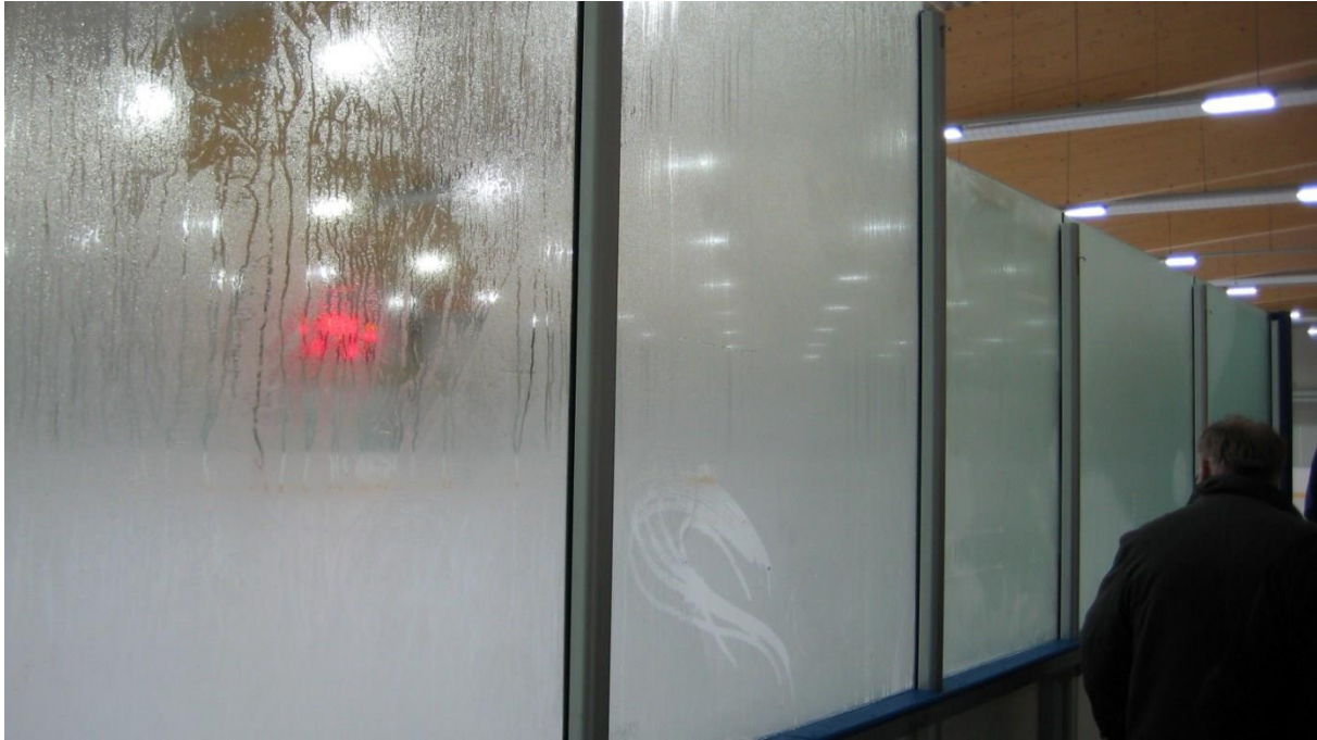
Figur 13- Kondensasjon på vantet i en ishall (Rogstam et al. , 2017)
