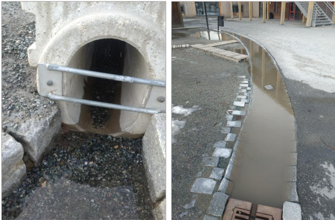
Figur 27. Illustrasjon over tilstanden til slisserennene da all snø og is hadde smeltet.
