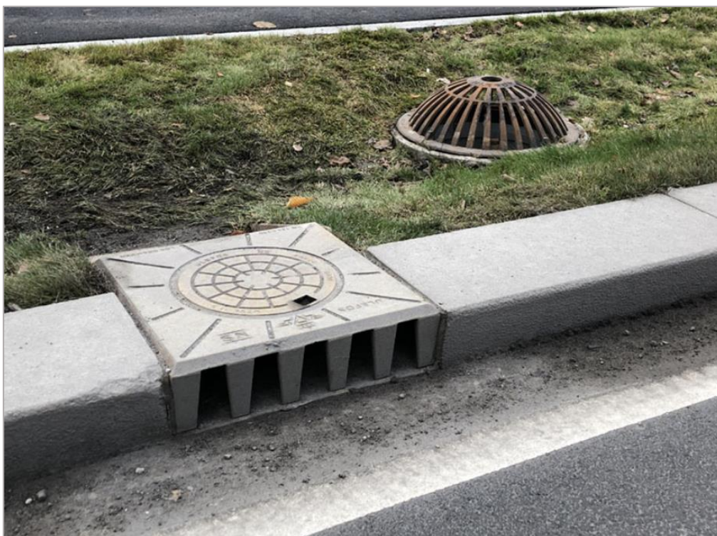
Figur 37. Illustrasjon av kjeftsluk langs vegkanten. I bakkant vises en kuppelrist (Olsen, 2018).
