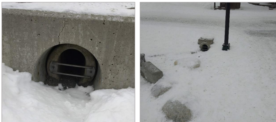
Figur 25. Selve slisserennene var helt dekket av snø og is, men utløpene var i stor grad snø- og isfrie.
