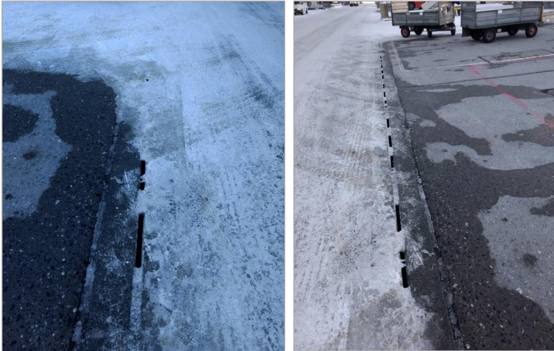
Figur 33. Bildet til venstre illustrerer tilstanden til slisserennene mellom oppstillingsplassene. Bildet til høyre viser tilstanden ved oppstillingsplassene.
