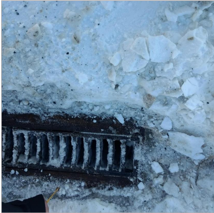
Figur 29. Slukristene ble gravd fram og istykkelsen målt til 7–8 cm.
