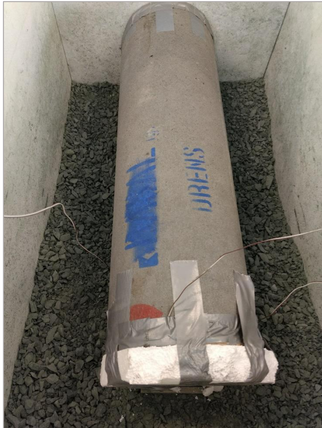
Figur 20. Endestykkene til røret ble isolert med 3 cm tykke EPS-plater.
