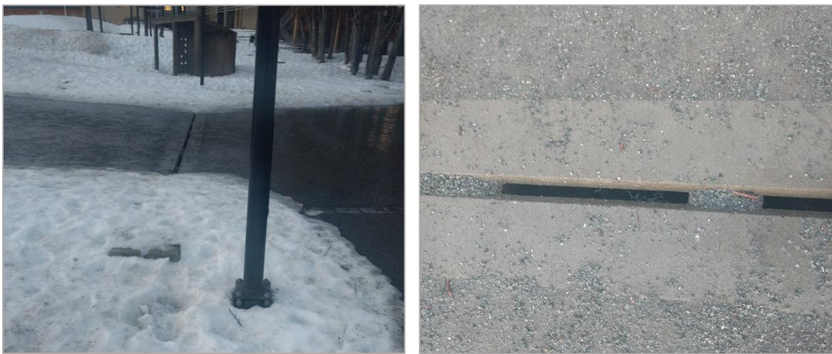
Figur 23. Illustrasjon over tilstanden til slisserennene etter høye temperaturer og 12,1 mm regn.
