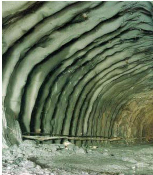
Figur 3.7 Armerte sprøytebetongbuer (Sve et al., 2008).
