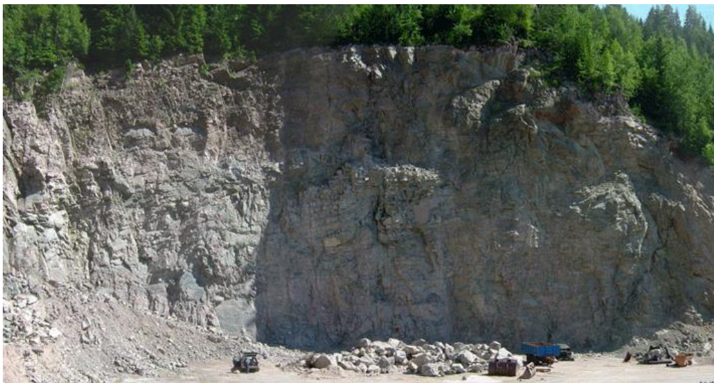
Figur 10.3: Oversiktsbilde fra pukkverket på Grindheim, som viser en relativt oppsprukket granitt. Hentet fra NGU (2019b).
