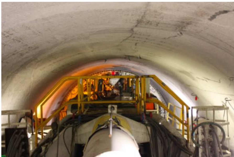
Figur 6.5: Fullprofilboring av tilløpstunnel ved Nedre Røssåga kraftverk i 2013. Den jevne og sirkulære konturen bidrar til lavere falltap under kraftproduksjon, sammenlignet med en konvensjonelt drevet tunnel med samme tverrsnittsareal. Hentet fra Dammyr (2017).
