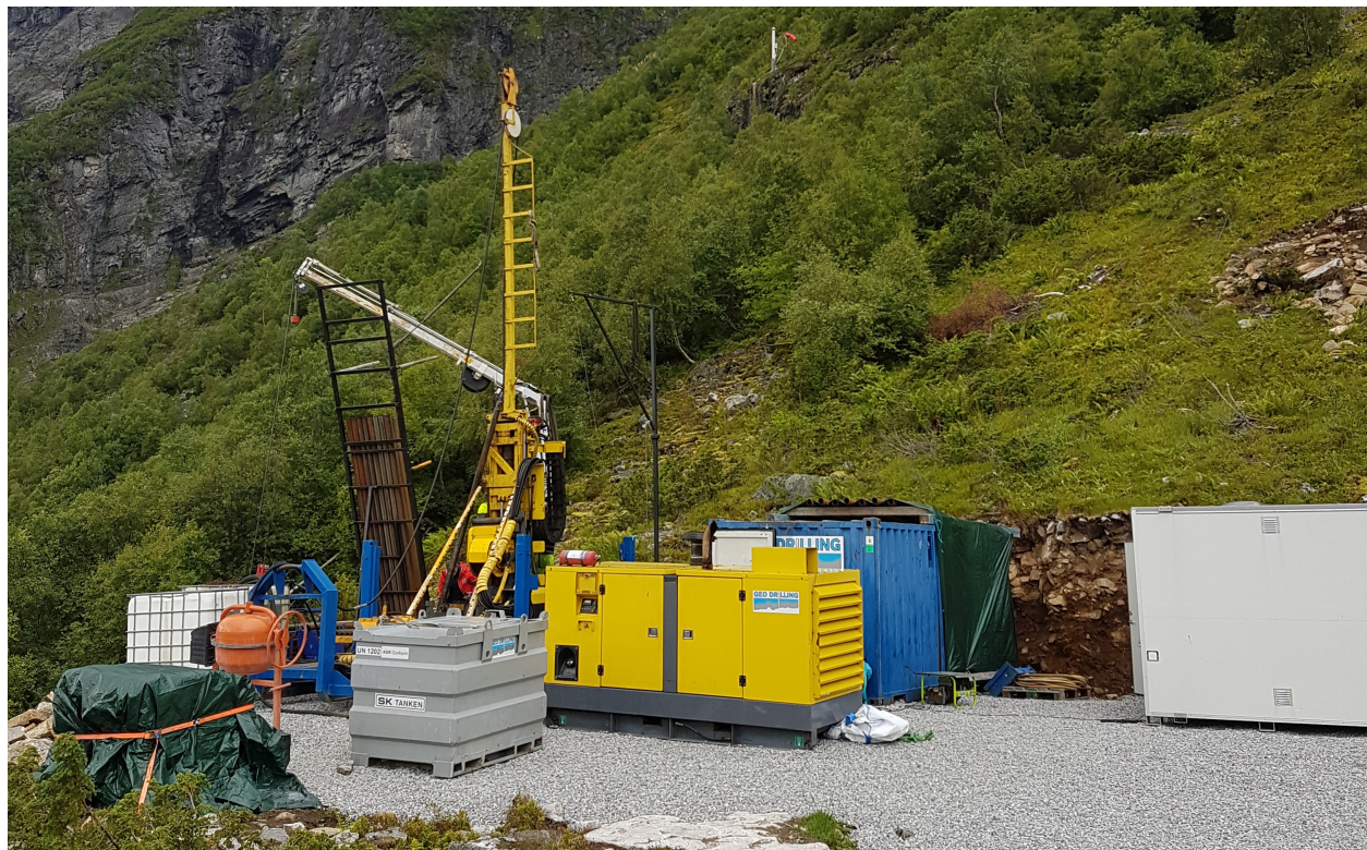
Figur 4.1: Boreriggen ved KH-01-17 sommeren 2017. Foto: Gustav Pless/NVE
