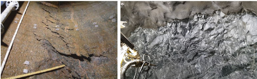
Figur 3.13: Flere stabilitetsproblemer kan oppstå avhengig av bergmassen og dens spenninger. Til venstre vises sprak fra Martin og Christiansson (2009). Til høyre vises blokkdannelse og utfall fra Soknedalstunnelen.
