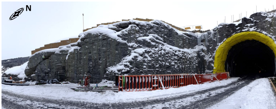
Figur 9.13: Den kartlagte skjæringen ved påhugg sør sett fra øst mot vest. Boravvik har ført til at vegg har ulik helning på delen lengst vekk fra tunnelen.
