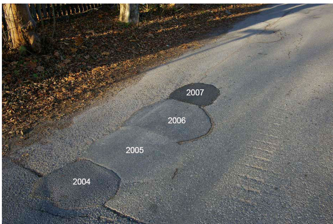
Fig. 7 Asfaltskader må utbedres årlig etter graving dersom arbeidet ikke gjøres riktig
