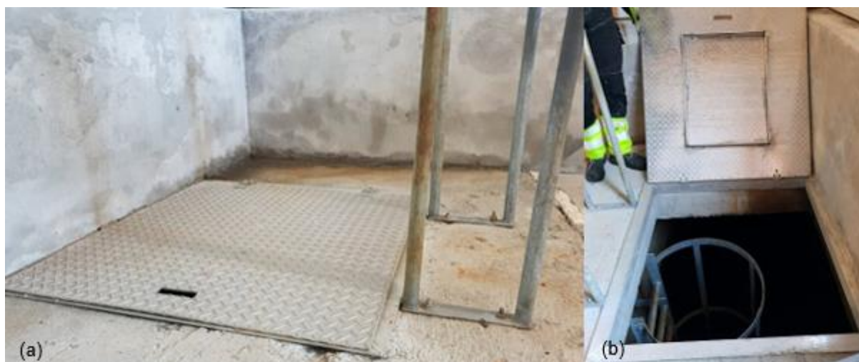
Figur 4.7: Innsiden av betjeningshus i drikkevannsbasseng 3.3. (a) Tilgang til kammer via luker i gulvet. (b) Viser tilgang ned til vannkammer og innsiden av luken (Foto: eget)
