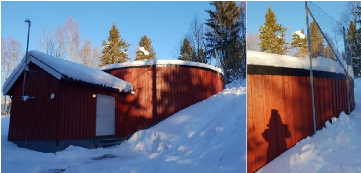
Figur 4.1: Drikkevannsbasseng 1.1 med snødekt tak (Foto: eget)
