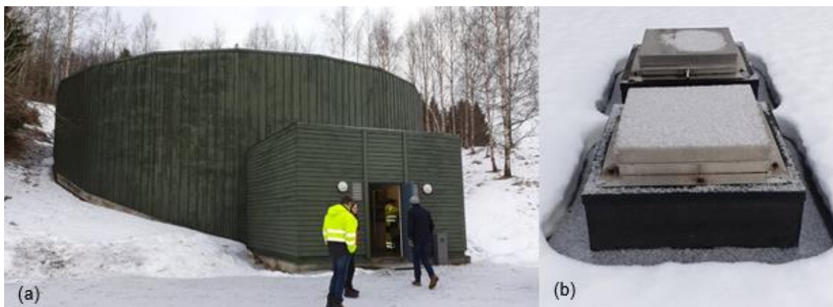
Figur 4.11: (a) Drikkevannsbasseng 4.2 er bygd med to kammer bestående av betong. (b) Tilgang til kamrene er via takluker (Foto: eget)
