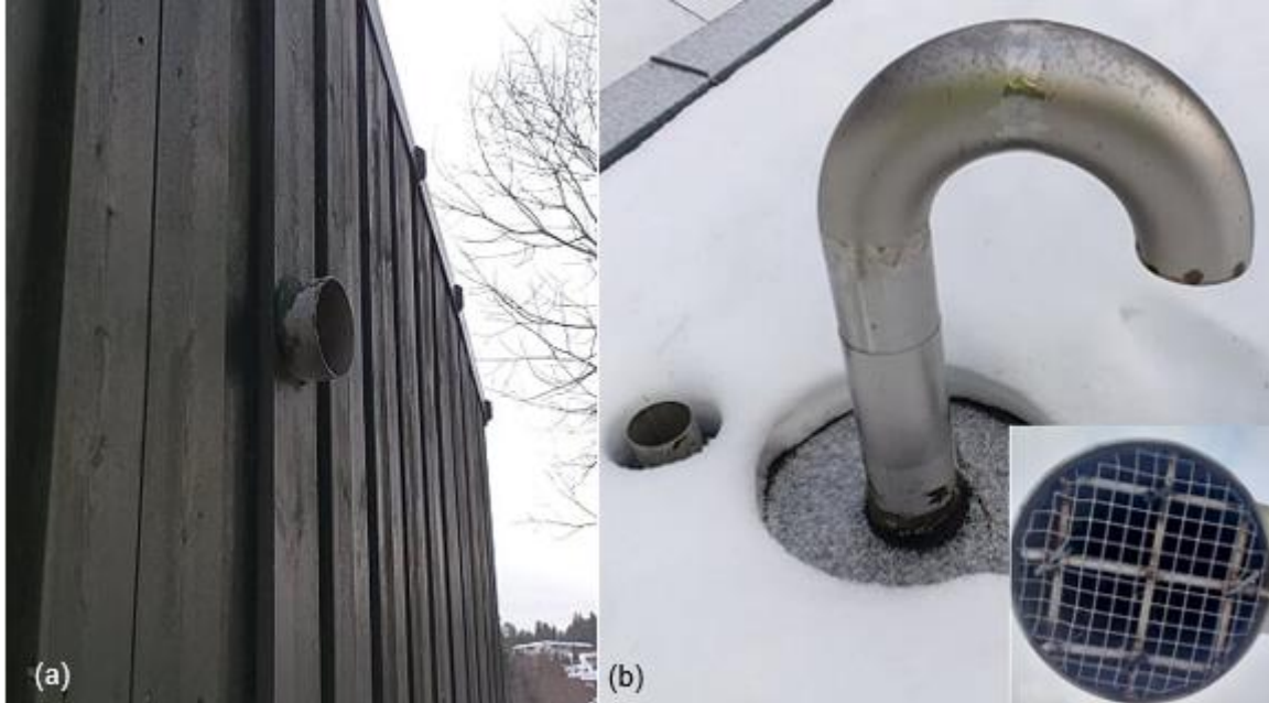
Figur 4.13: (a) Utvendig avrenning ved tilfeller av mye vann på taket for drikkevannsbasseng 4.2. Vannet renner gjennom røret (b) og kommer ut (a). (b) Ventilasjon av bassenget er ved bruk av svanehals med grov netting (Foto: eget)
