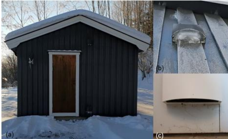
Figur 4.8: (a) Drikkevannsbasseng 3.3 består av to nedgravde kammer av betong. Det er bygd et betjeningshus på toppen. (b) og (c) viser ventilasjon. (Foto: eget)
