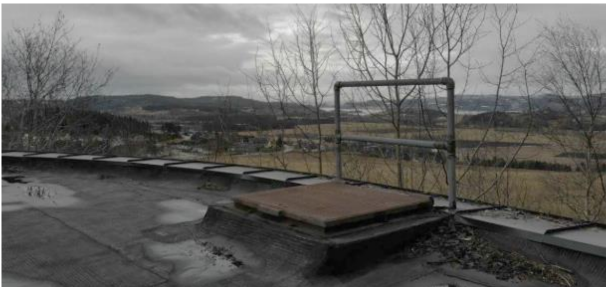
Figur 4.18: Nedstigningsluke for tilgang til vannkammer for drikkevannsbasseng 6.1 (Foto: Dillan Ø., Mattilsynet)
