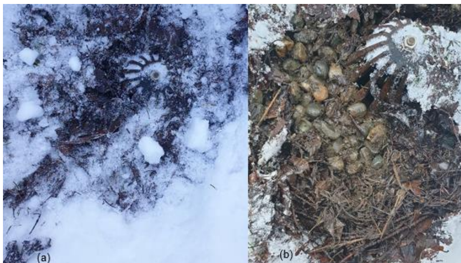
Figur 4.15: Sluk på tak for innvendig taknedløp for drikkevannsbasseng 5.1. (a) og (b) viser hvordan sluket ser ut før og etter det ble gravd frem (Foto: eget)
