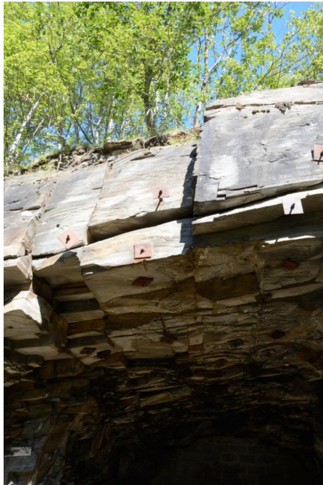
Figur 6 Inngangspartiet til Rupsi-stollen. Bildet viser tydelige blokkig berg med tre sprekkeretninger. Bilde tatt av undertegnede under befaring.
