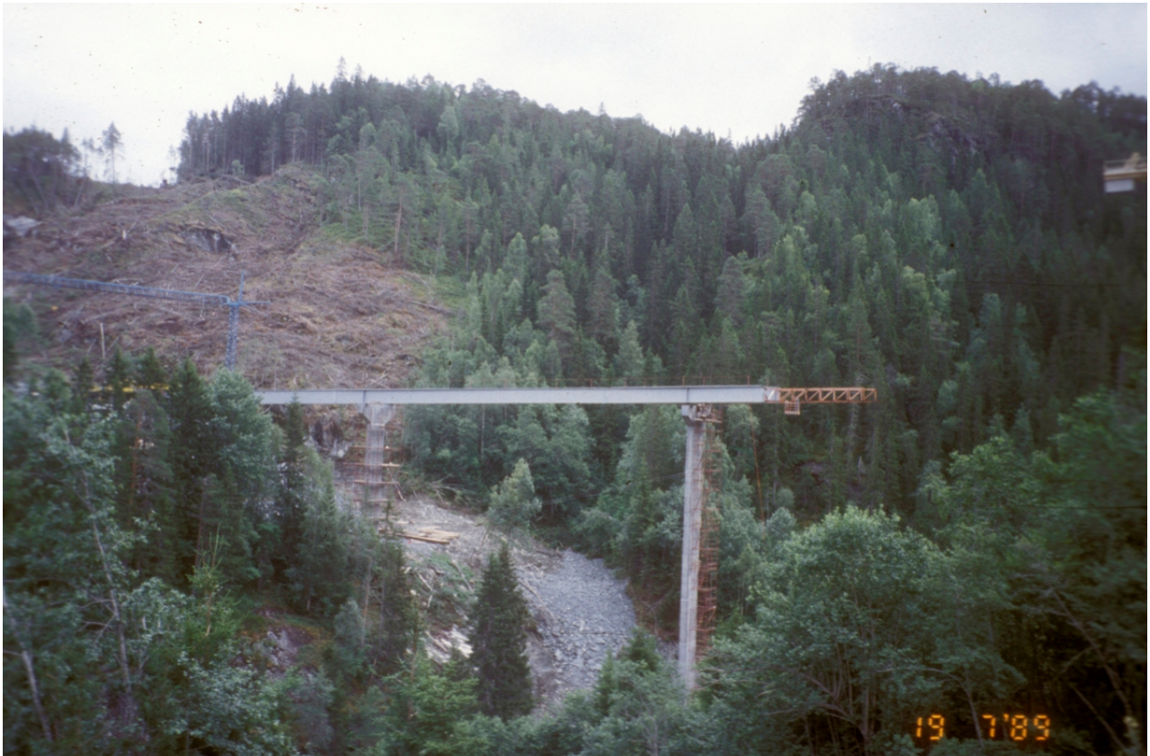
Figur 2.1.2: Bruen under bygging, bildet er hentet fra digitalt museum sine nettsider.
