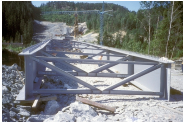
Figur 2.1.1: Stålbejelkene til eksisterende bru, bildet er hentet fra digitalt museum sine nettsider.
