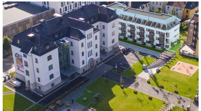
Figur 34: Fotografi bygg 1 (Kasernehagen) [47]
