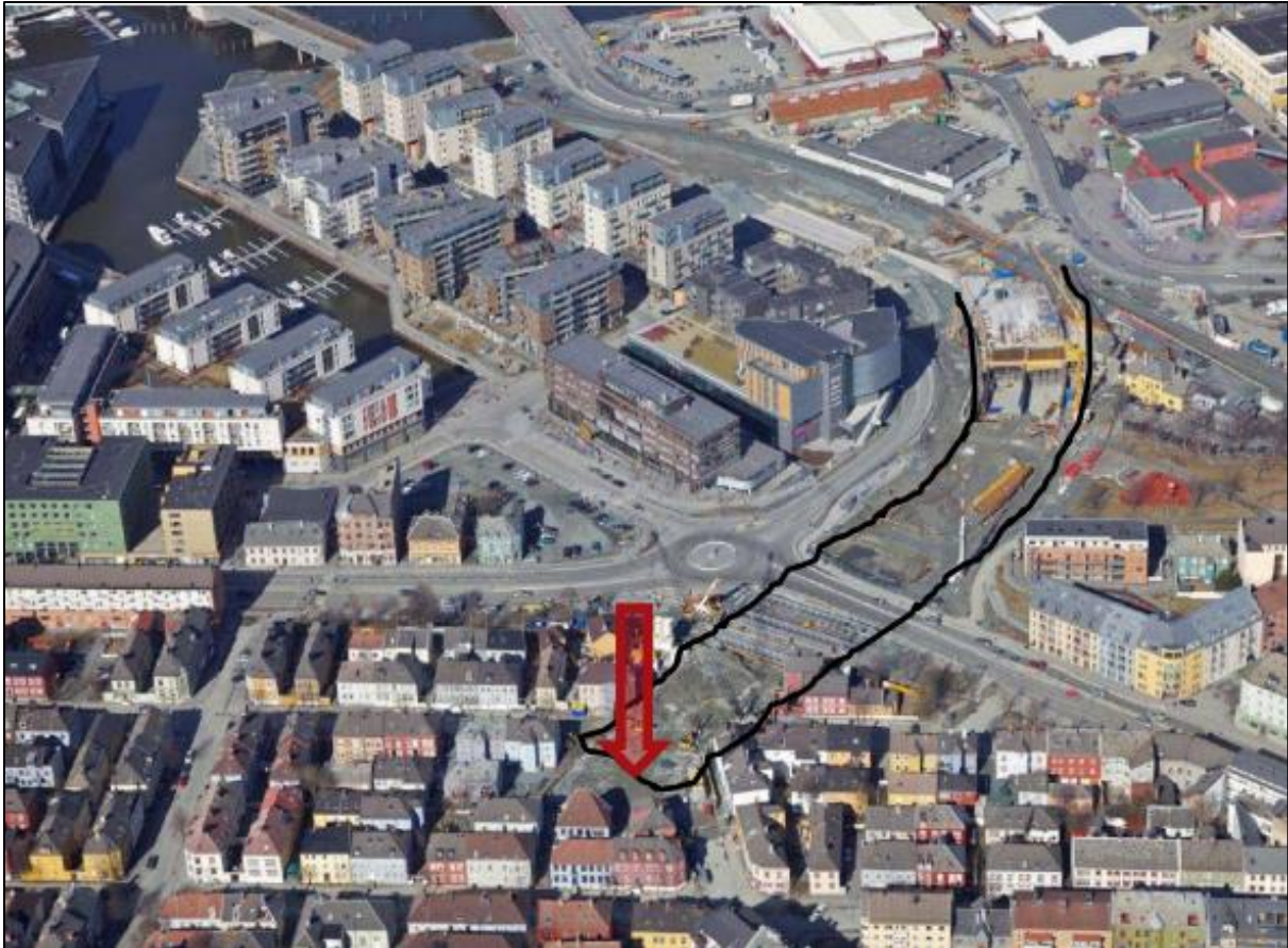
Bilde 1 Trangt ved påbygg ved Strindbeimtunnelen, Trondheim (Aagaard, 2014)
