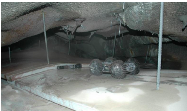
Figur 2.2: Fjernstyrt robot med påmontert kamera køyrer på baksida av henget, Frodeåstunnelen (Lindstrøm et al., 2013).
