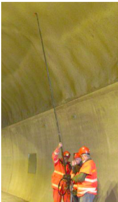
Figur 2.1: Teleskopstong med påmontert kamera kan brukast ved tunnelinspeksjon, her frå Frodeåstunnelen (Lindstrøm et al., 2013).
