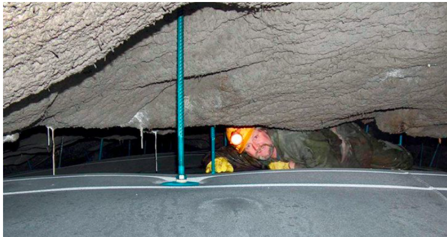
Figur 1.3: Plassen bak tunnelkvelv kan vere liten og ikkje eigna for inspeksjon. Illustrasjonsbilette henta frå: Aftenposten/ Scanpix
