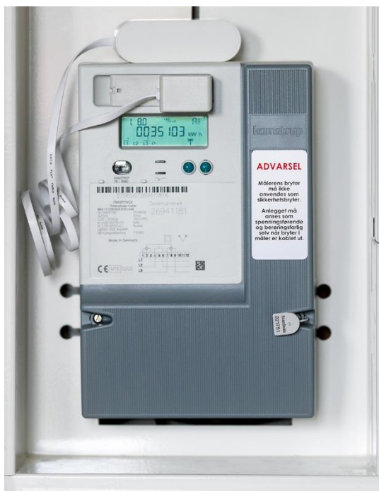
Figur 23: Ewave AS sitt produkt koblet til en Kamstrup-måler. Hentet fra ewave.no.
