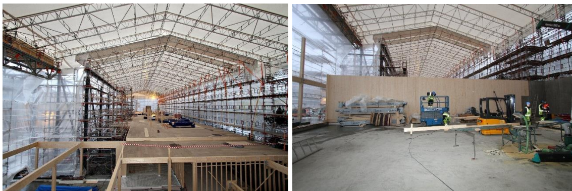
Figur 2.9: Fuktsikring med teltbasert system (tu.no)
