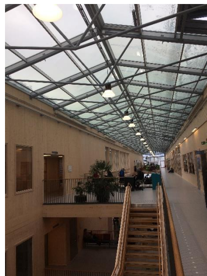
Stålfagverket er noe av det eneste bærende ikke i massivtre.
