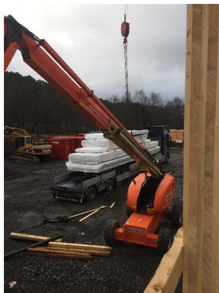
Elementer heises av lastebilen.
