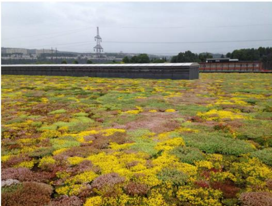
Figur 2.20: Eksempel på ekstensivt grønt tak. Foto: UMB (Hentet fra Grønne tak, SINTEF Byggforsk 2012)
