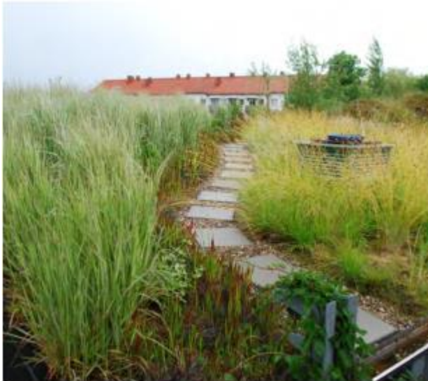
Figur 2.21: Eksempel på semi-intensivt tak. Foto: ILP/UMB (Hentet fra Grønne tak, SINTEF Byggforsk 2012)
