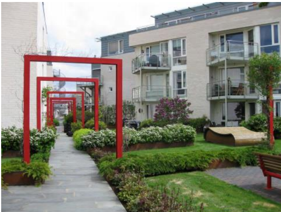
Figur 2.22: Eksempel på intensivt grønt tak. Foto: SINTEF Byggforsk (Hentet fra Grønne tak, SINTEF Byggforsk 2012)
