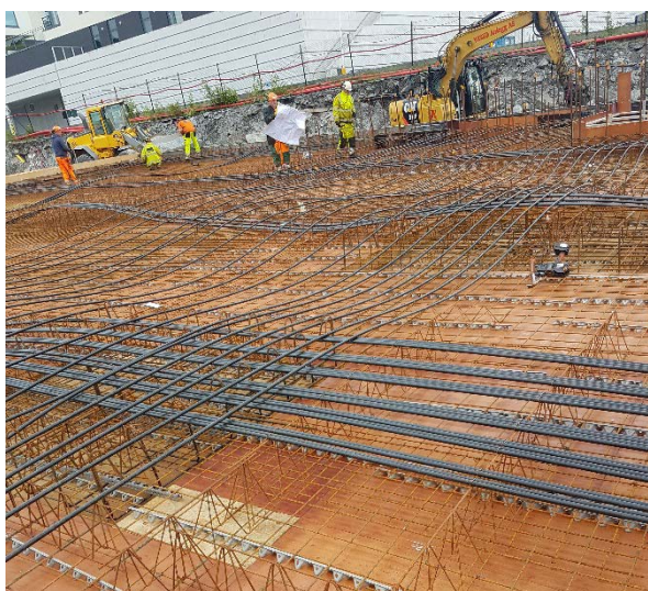
Figur 2-3 Plassering av spennkabler. Fra befaring på Fri sikt, voldsalsberga
