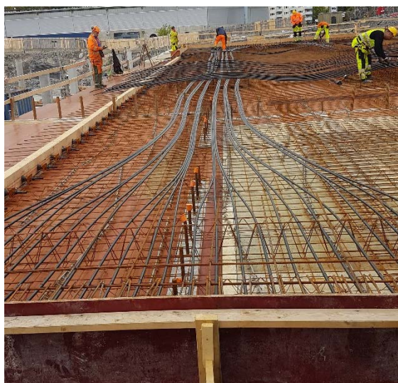
Figur 2-4 Klargjøring til støp. Fra befaring på Fri sikt, Volsdalsberga
